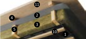
Цокольное перекрытие (вид со стороны холодного подпола)
