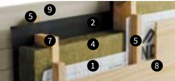
Каркасная стена (вид изнутри)
