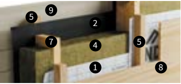
Каркасная стена (вид изнутри)
