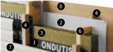
Каркасная стена (вид снаружи)
