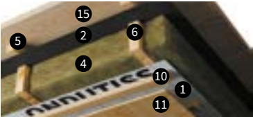
Чердачное перекрытие (вид со стороны тёплого помещения)
