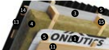
Утеплённая кровля и мансарда (вид изнутри)
