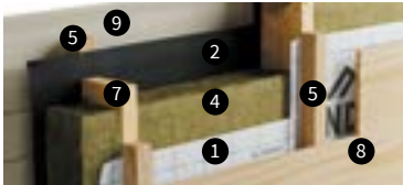
Каркасная стена (вид изнутри)
