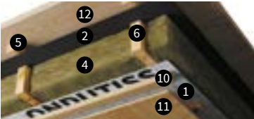
Утеплённое чердачное перекрытие (вид со стороны тёплого помещения)
