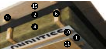
Чердачное перекрытие (вид со стороны тёплого помещения)
