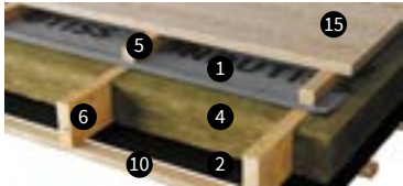
Цокольное перекрытие (вид со стороны тёплого помещения)
