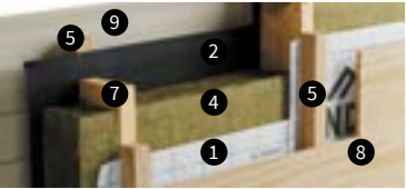
Каркасная стена (вид изнутри)
