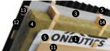
Утеплённая кровля (вид изнутри)
