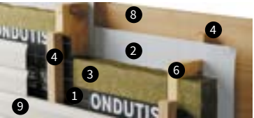
Каркасная стена (вид снаружи)
