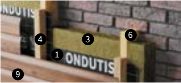
Стена с наружным утеплением
